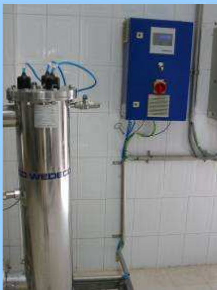
Stérilisateurs U. V., Eau de Process 35 m 3 /h et Eaux usées 1500 m 3 /j
