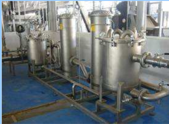
Palette de filtration de 25 à 1 micron ( \mu ), 80 m 3 /h
