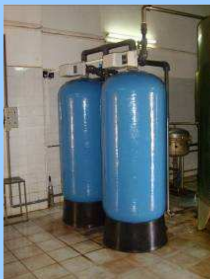
Unités de déferrisation et démanégnisation 10 et 120 m 3 /h
