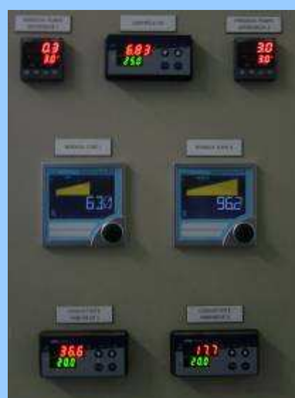
Unités de mesure et contrôle pilotant des process globaux, ex. station Ultra Filtration 80 m 3 /h
