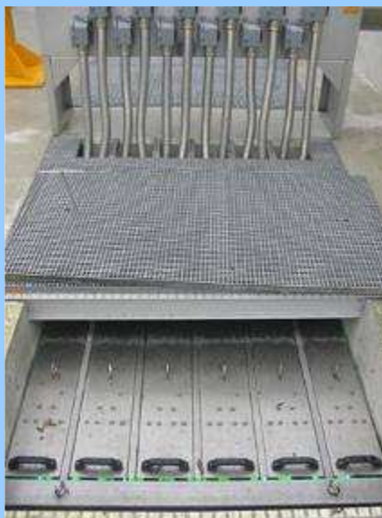
Stérilisateurs U. V., Eau de Process 35 m 3 /h et Eaux usées 1500 m 3 /j
