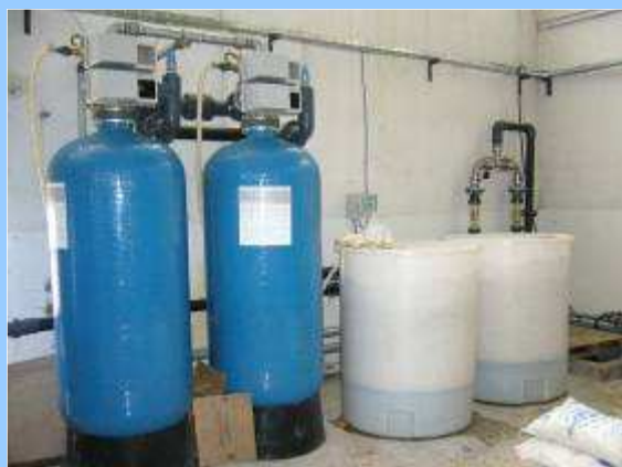
Unités de dénitrations avec des résines sélectives échangeuses d'ions, 25 et 55 m 3 /h
