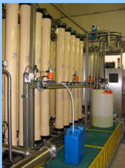
Unités de mesure et contrôle pilotant des process globaux, ex. station Ultra Filtration 80 m 3 /h
