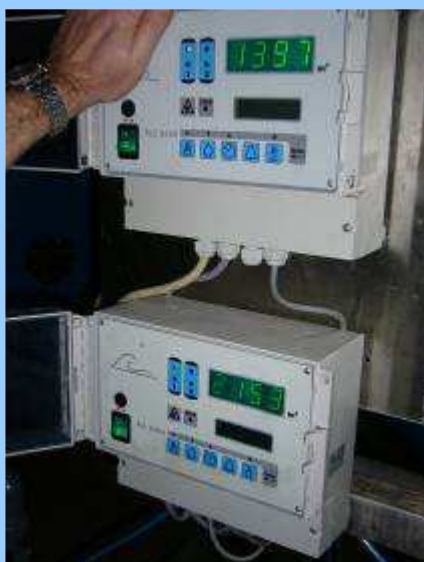
Unités de mesure et contrôle pilotant des process globaux, ex. station Ultra Filtration 80 m 3 /h
