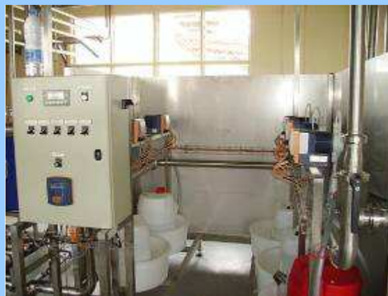
Générateur Ozone, Unité de mesure en ligne, Station de reminéralisation 5 dosages
