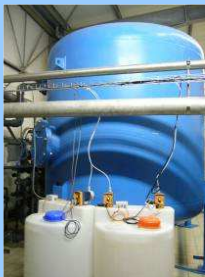
Unités de déferrisation et démanégnisation 10 et 120 m 3 /h
