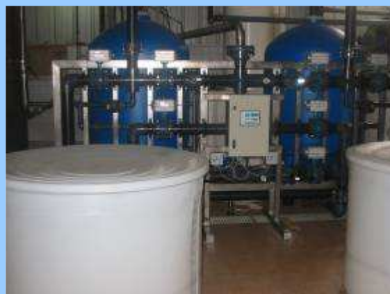
Unités de dénitrations avec des résines sélectives échangeuses d'ions, 25 et 55 m 3 /h
