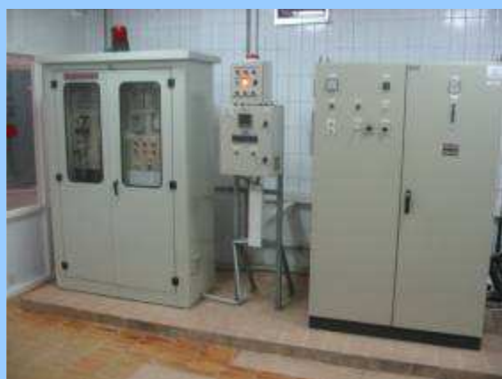
Générateur Ozone, Unité de mesure en ligne, Station de reminéralisation 5 dosages
